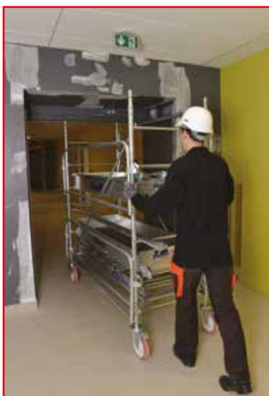
Passage dans les portes de 0,83 m.
