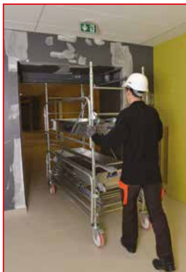
Passage dans les portes de 0,83 m.
