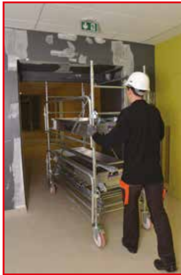
Passage dans les portes de 0,83 m.
