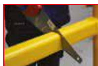
Découpe des lisses facile avec une scie
