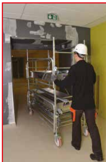
Passage dans les portes de 0,83 m.
